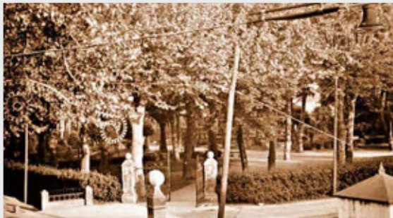
Imaxe da entrada principal localizada nun lateral. Década de 1920
