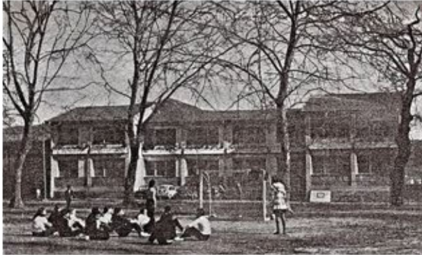
Antigo edificio de Bacharelato, actual Auditorio Municipal
