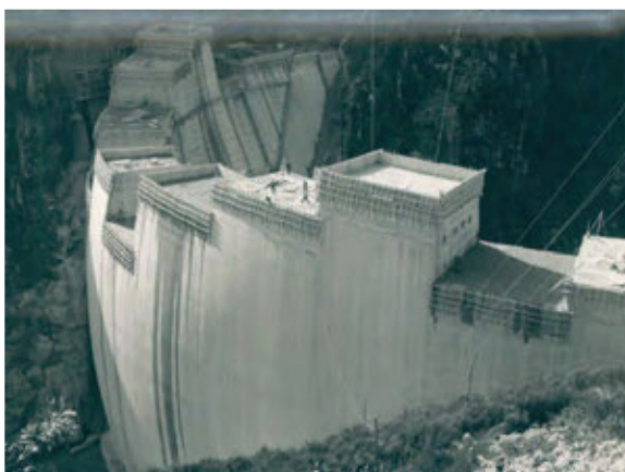
Figura 226 y 227. Vista general de las cabezas de las ménsulas y de las maderas de un encofrado. A. Martí. ADC.
