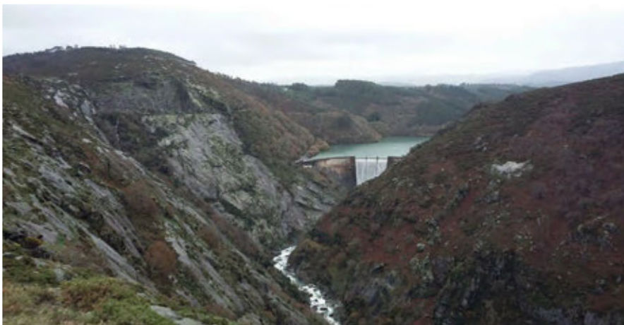
Figura 280. Panorámica aguas arriba con la presa terminada. A. Martí. ADC.
