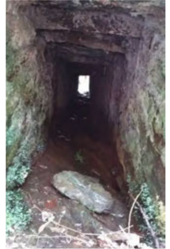
Figura 32. Tajea de la pista de la cantera. Foto de los autores.
