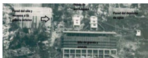
Figura 108. Torres de secundarios con el silo cubierto abajo. CGAI-II.
