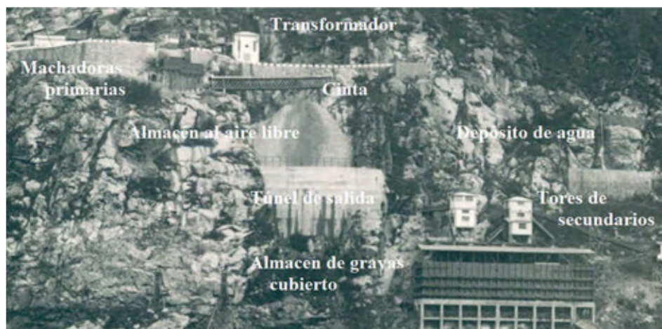
Figura 98. Elementos básicos de la unidad de áridos. CGAI II.
