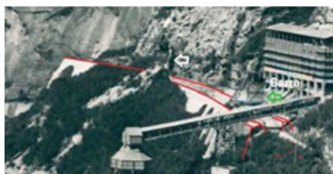
Figura 137. Estructura de la plataforma en la que están las guías. A. Martí. ADC.
