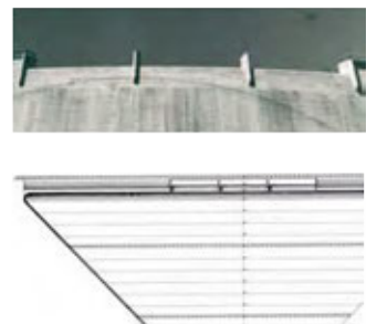
Figura 267 y 268. El aliviadero visto desde aguas arriba y el puente que corona la presa.
