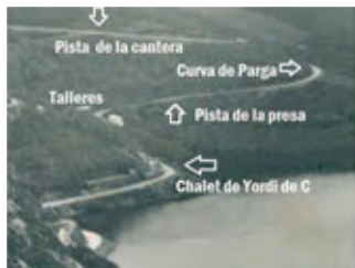
Figura 22. Pista de acceso a la presa y a la cantera. A.Martí. ADC.
