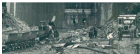
Figura 70. Trabajos en la solera de la presa. A. Martí. ADC.
