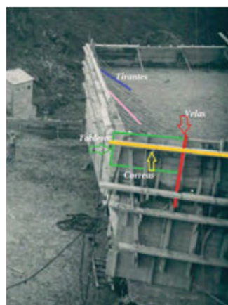
Figura 226 y 227. Vista general de las cabezas de las ménsulas y de las maderas de un encofrado. A. Martí. ADC.
