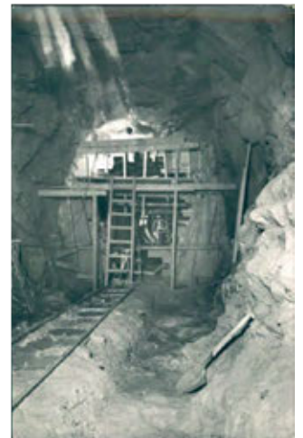
Figura 167. Vista del túnel con la roca visible. A. Martí. ADC.
