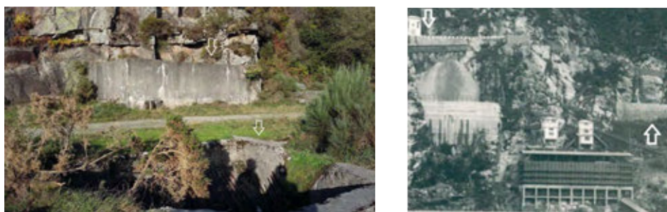
Figuras 56 y 57. Depósito de la cantera y balsa de la vaguada. Autores y A. Martí. ADC.
