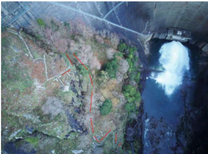
Figura 49. Escaleras que bajan al cauce. David Couce
