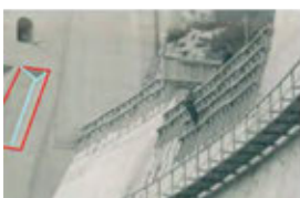
Figura 260. Desencofrando y visión de la junta. A. Martí. ADC.
