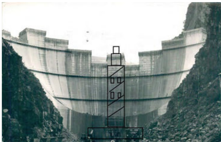
Figura 235. Ejemplificación de la altura desde aguas abajo. A. Martí, ADC y autores.
