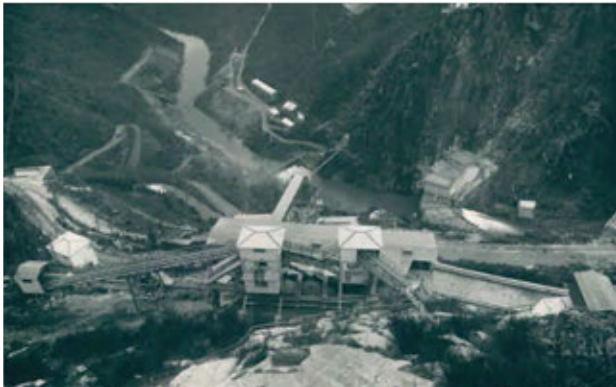
Figura 113. Toma del conjunto en los primeros meses de trabajo en la presa. A. Martí. ADC.
