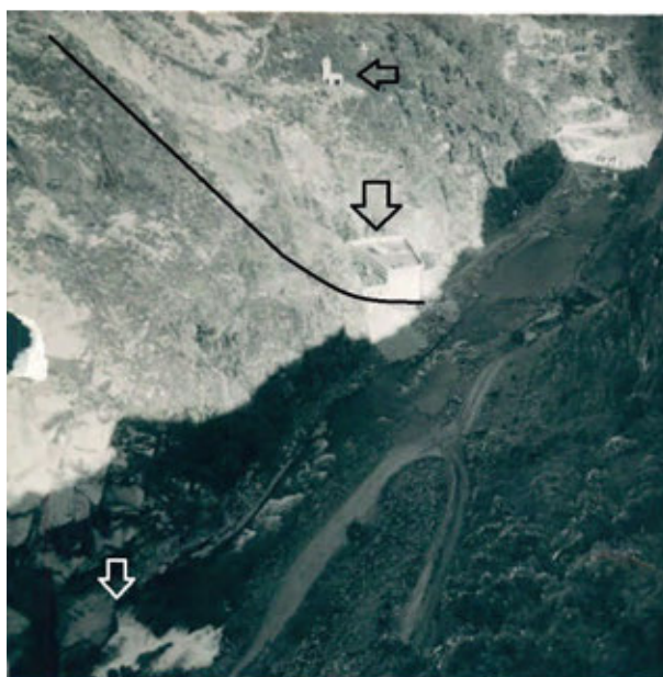
Figura 196. Visión del cauce y del estribo derecho desde aguas abajo. A. Martí. ADC.
