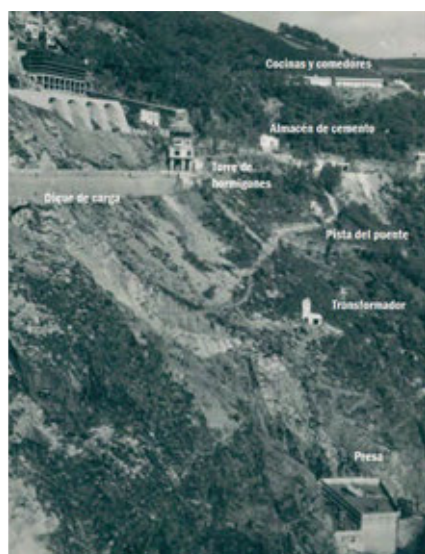
Figura 121. Visión del depósito de cemento. A. Martí. ADC.
