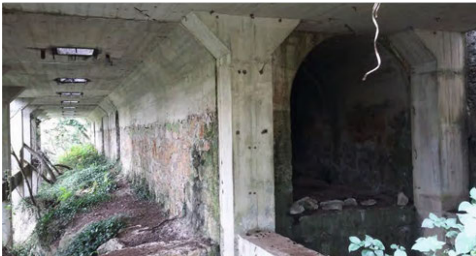
Figura 111.- Soporte del almacén cubierto y galería de la cinta de transporte. Autores.
