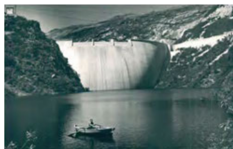
Figura 279. La bóveda abrazando los macizos. Yordi. ORP 1973.
