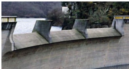
Figura 264. Aliviadero de superficie. A. Martí. ADC.
