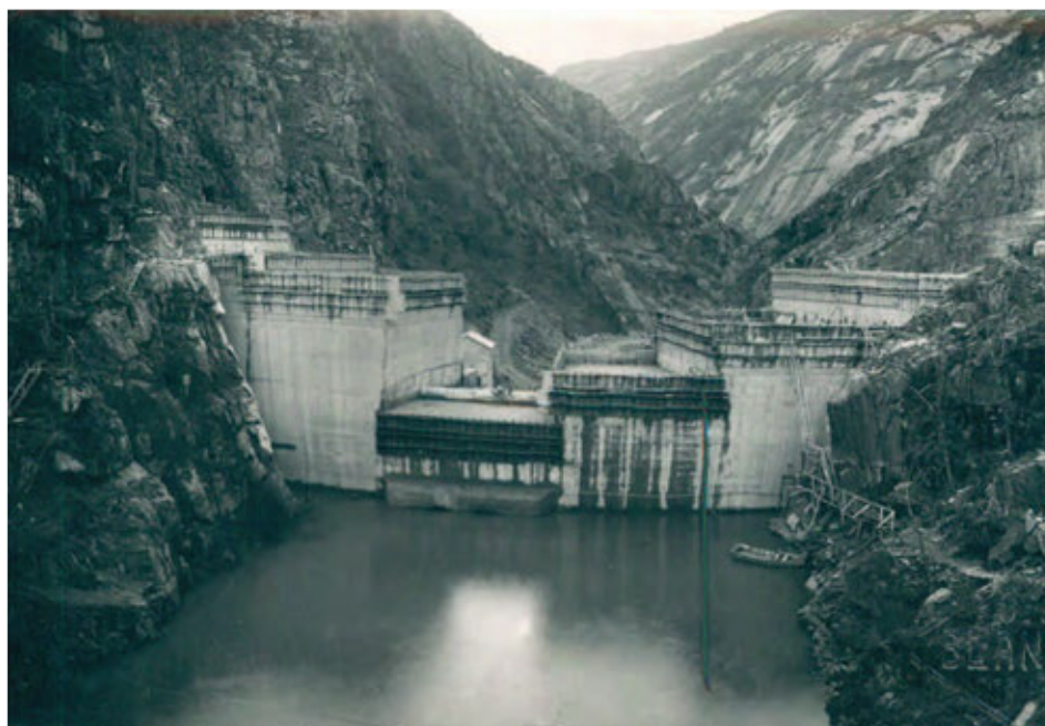
Figura 209. Vista de la presa desde aguas arriba. A. Martí. ADC.
