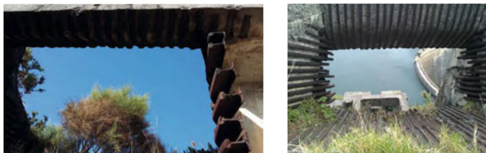
Figura 106 y 107. Bocas de carga desde arriba y desde el interior. Autores.
