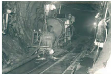
Figura 166. Equipo preparado para el recubrimiento. A. Martí. ADC.
