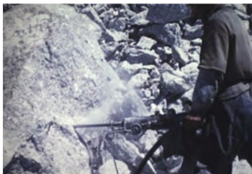
Figura 94. Reduciendo a trazos manejable los grandes bloques. CGAI-I.
