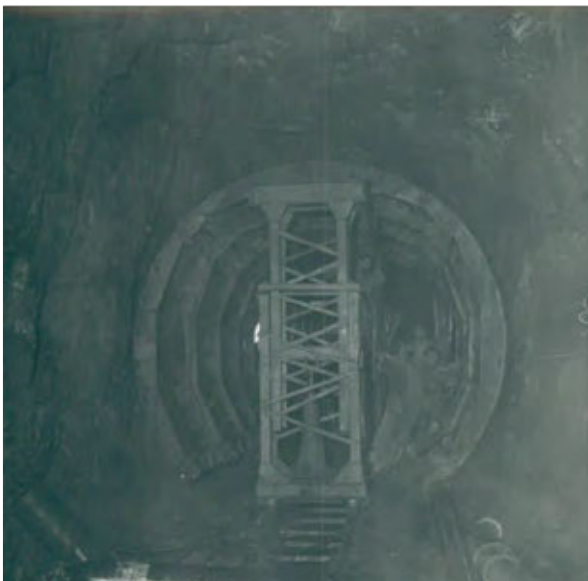
Figura 168. El túnel con el recubrimiento. A. Martí. ADC.
