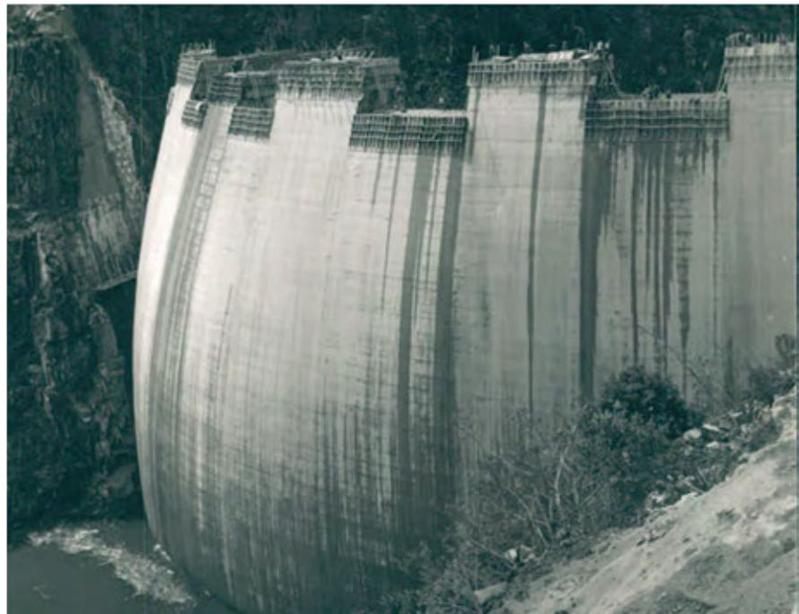
Figura 274. Imagen que hace visible la curvatura de la presa aguas arriba.
