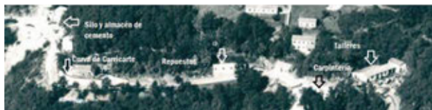
Figura 62. Imagen parcial de los talleres. A. Martí.
