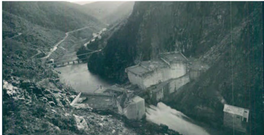
Figura 204. Los aliviaderos de fondo liberan el agua acumulada. A. Marti. ADC.
