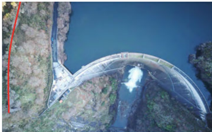
Figura 131. Vista aérea de la garganta con la curva de las guías marcada. D. Couce.
