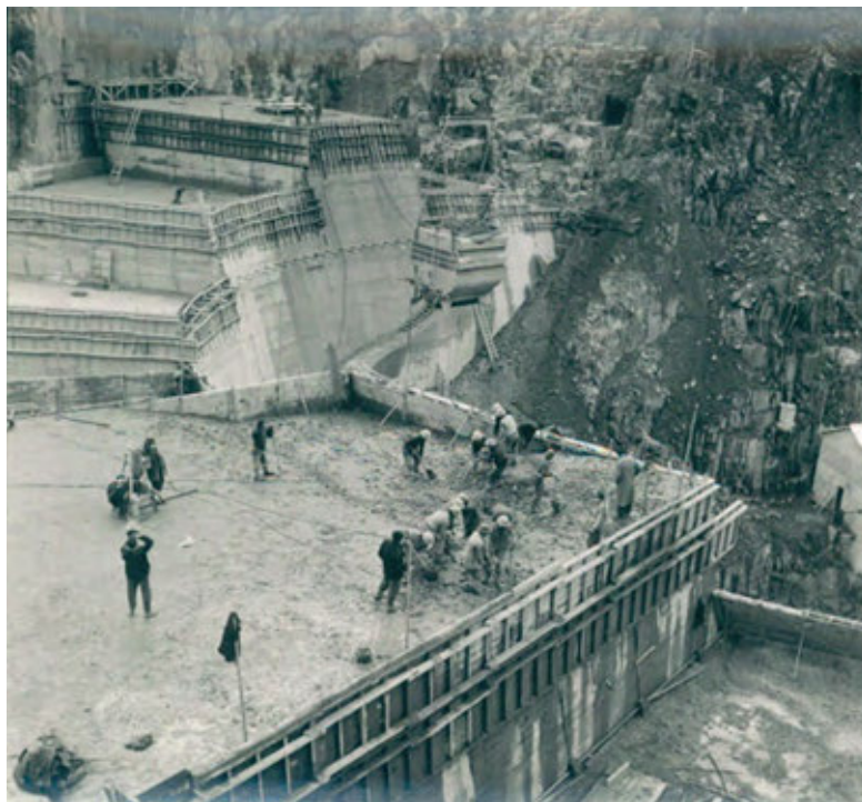
Figura 214. El blondín bajando y los hombres terminando el bloque. A. Martí. ADC.
