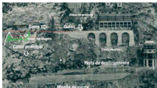
Figura 130. Guías del blondín y contrafuertes. A. Martí.
