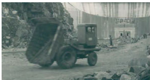
Figura 60. Dumper de Dragados trabajando en el cauce. A. Martí. ADC.
