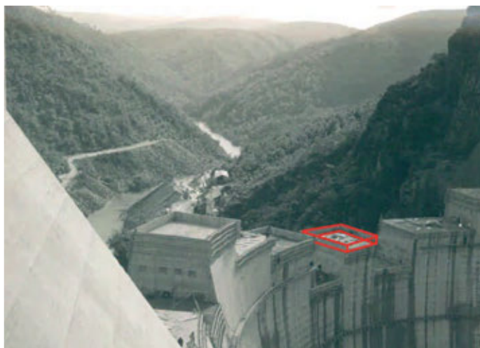
Figura 228. Toma general desde aguas abajo. A. Martí. ADC.
