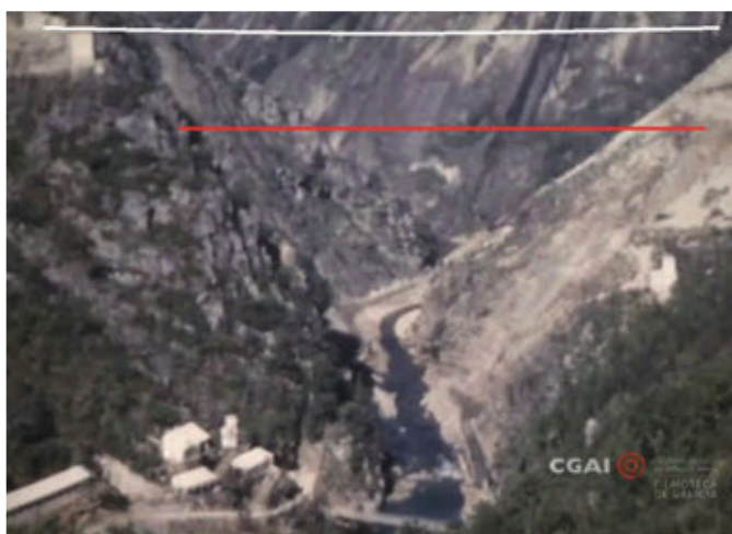
Figura 125. Garganta con la altura de la presa y la línea del cable grúa. Autores.
