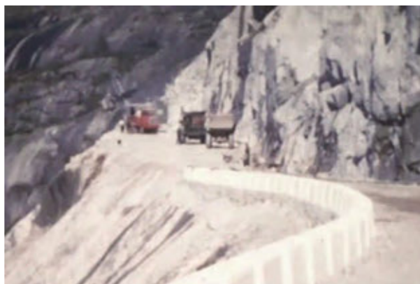
Figura 87. Pista que lleva a la cantera y los camiones esperando por su carga. CGAI-I.
