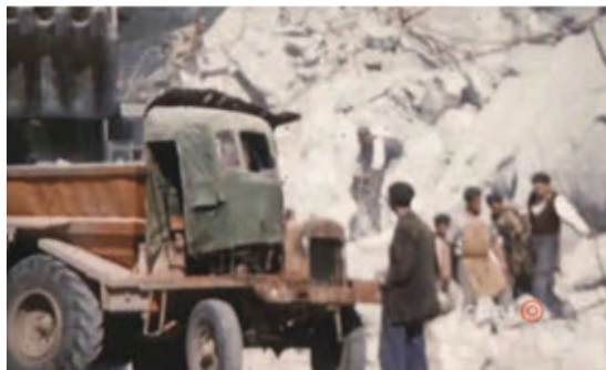
Figura 90. Cargando piedra en el dumper, el encargado y los hombres trabajando. CGAI-I.
