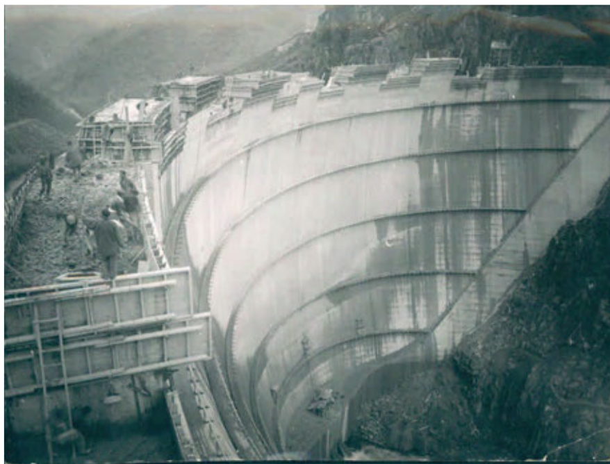
Figura 255. Últimos trabajos en la cresta de la presa. A. Martí. ADC.
