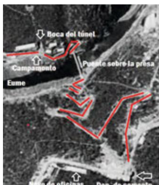
Figuras 34. Pista que baja al puente. Vuelo Americano.
