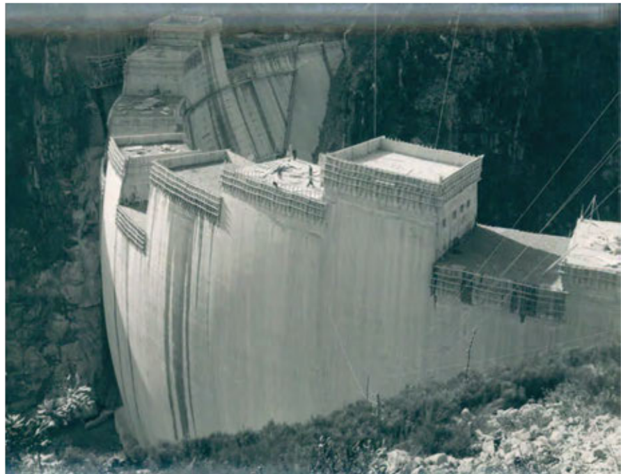
Figura 259. Enfoque de la construcción de los bloques desde aguas arriba. A. Martí.
