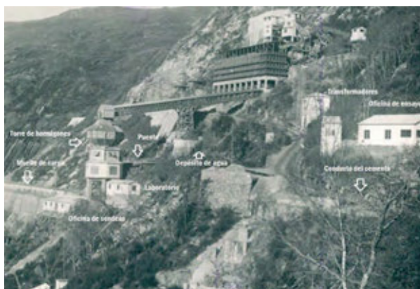
Figura 118. Conjunto de la torre con sus equipamientos. A. Martí. ADC.
