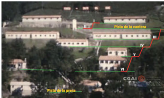
Figura 39. Vista parcial de la ladera con las plataformas de los pabellones. CGAI-I.
