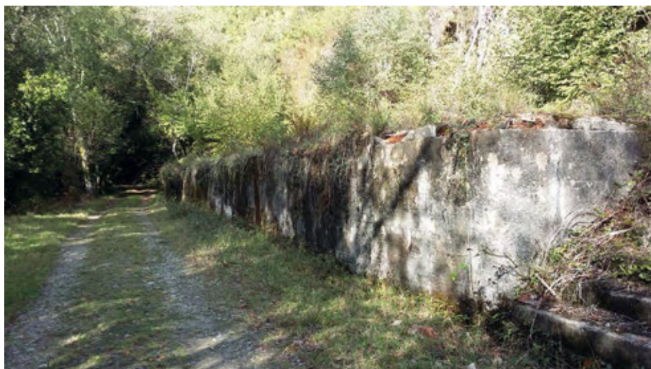
Figura 43. Zócalo del pabellón de cocina. Imagen de los autores.
