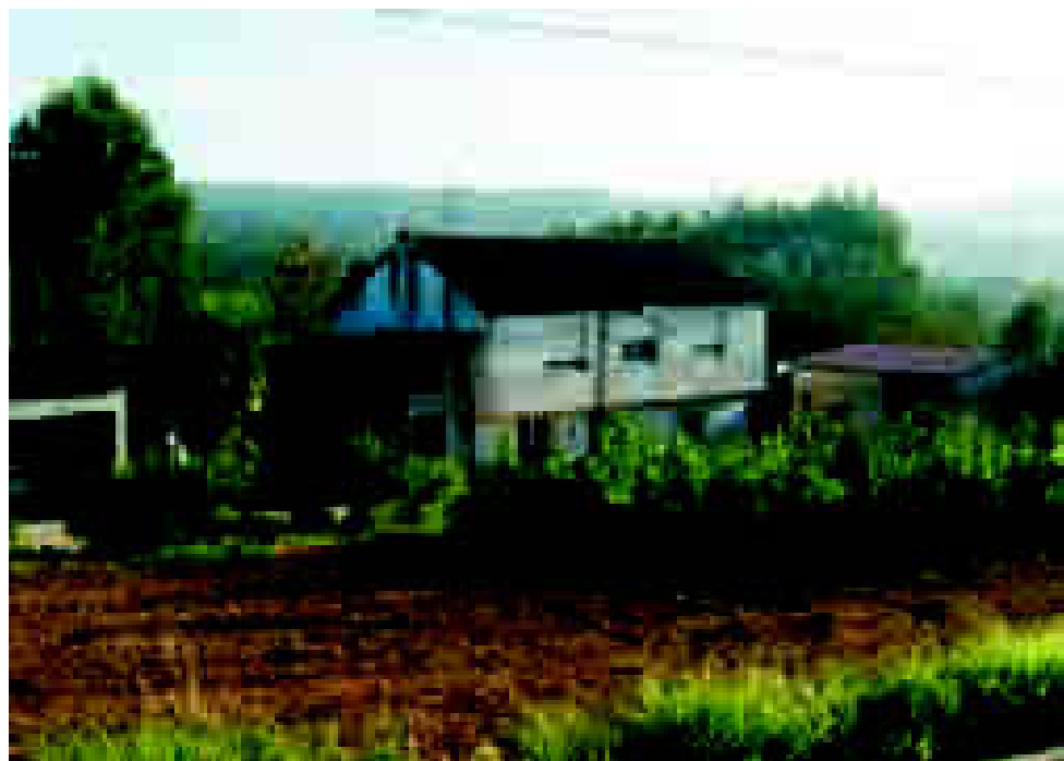
Vella casa de labrego transformada pola adición do voadizo, a apertura de ocós, a substitución da cuberta e o enfoscado.
