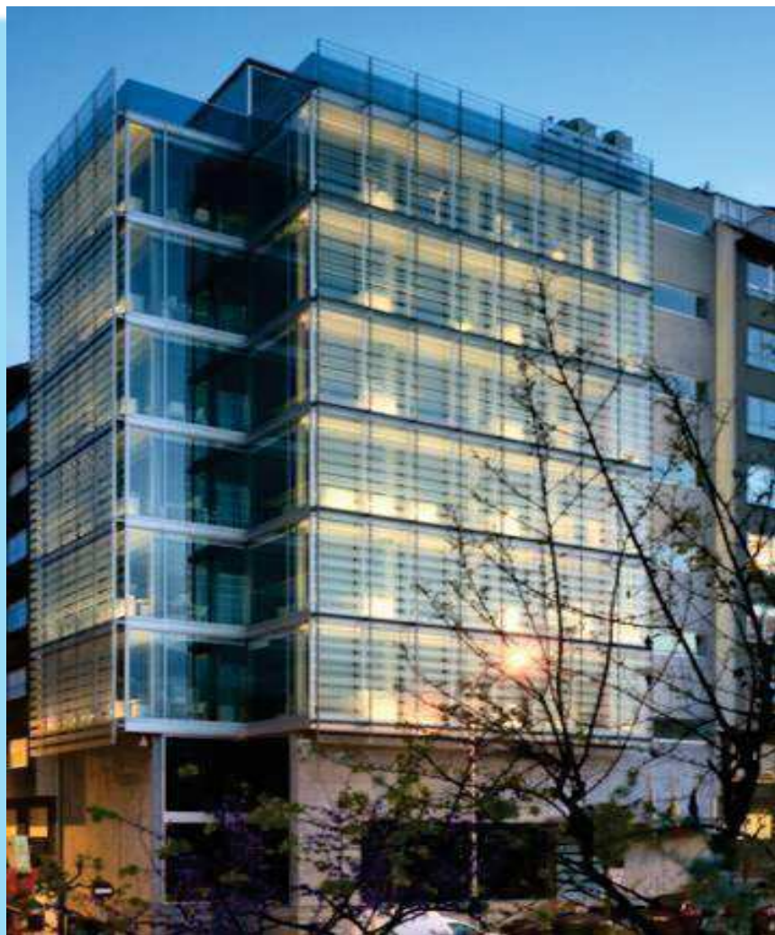
Sede Central de Recadación e Xestión Tributaria na rúa Míster Archer Milton Huntington (A Coruña).
