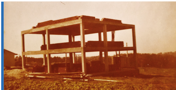
Casa a medio construír. M a Luisa Prieto
